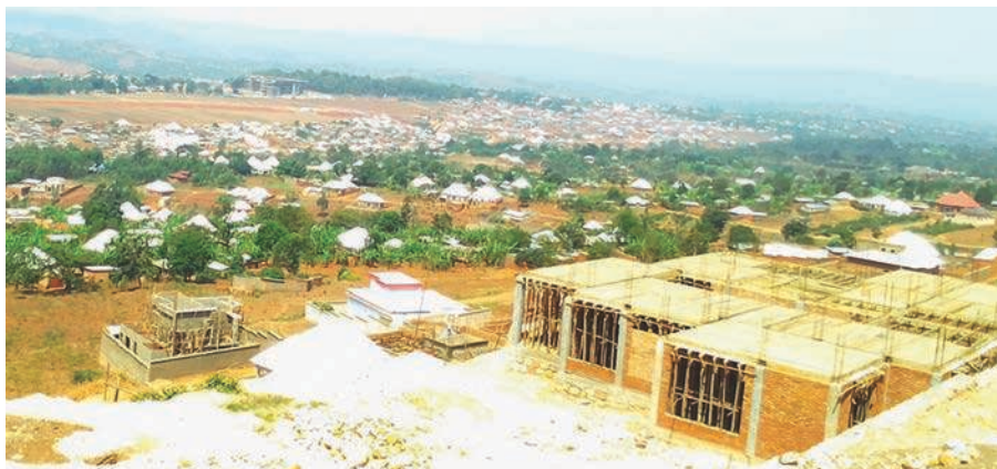
Fig. 7. Construction en cours de finalisation à Zege. Noter le recours au béton (gauche de l'image) et/ou la superficie des habitations (à droite de l'image). Source : Erasme Ngiye, 2023.
