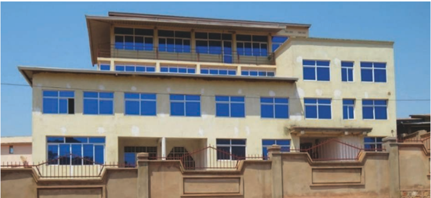
Fig. 5. Construction d'un hôtel à plusieurs étages et utilisant des matériaux tels que le béton et le verre (source : Erasme Ngiye, 2023).
