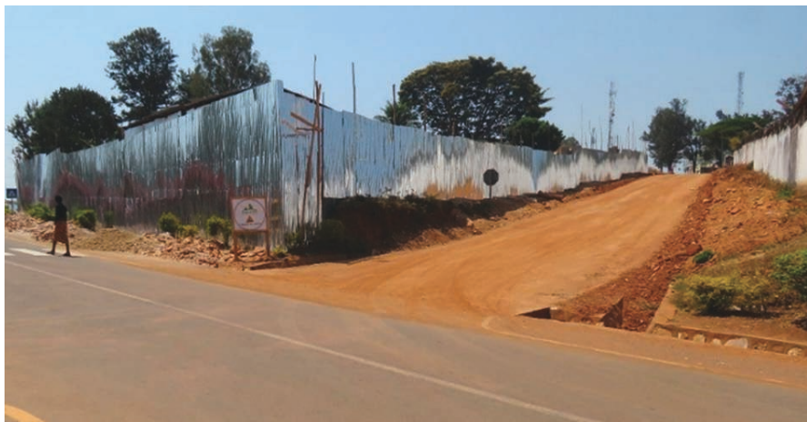
Fig. 8. Route en cours de bitumage près du Cercle de Gitega, en centre-ville (source : Erasme Ngiye, 2023).
