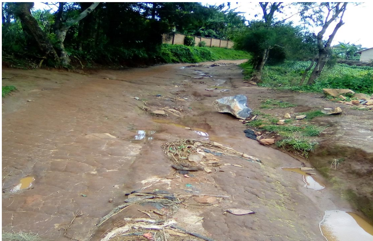
Photo 3.3: Création des rigoles par les eaux ruisselantes dans les avenues du centre urbain de Matana
