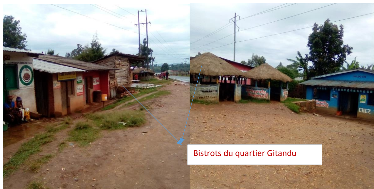
Photo 2.3: les bistrots du quartier Gitandu en mauvais état
