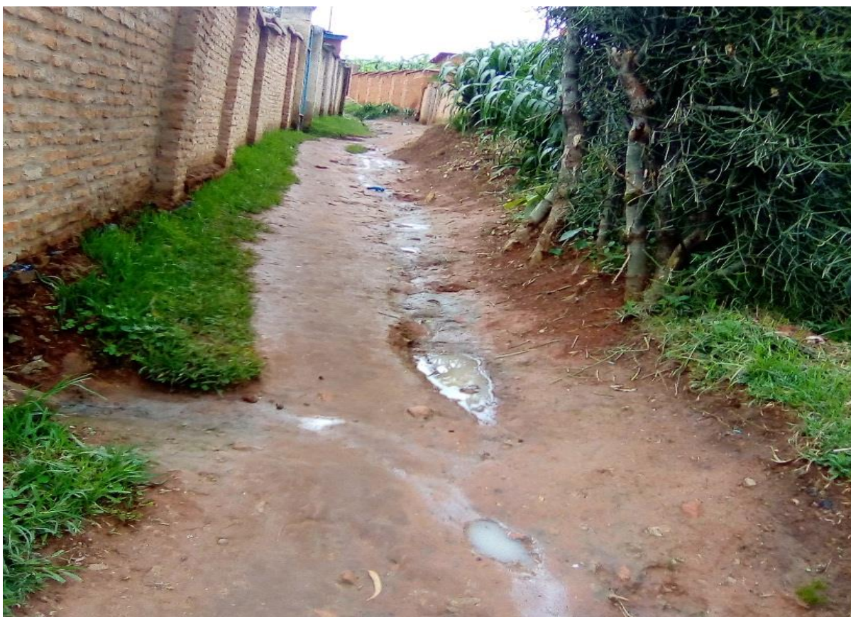
Photo 2.2: Présence de la voirie non planifiée dans le quartier Kigwati
