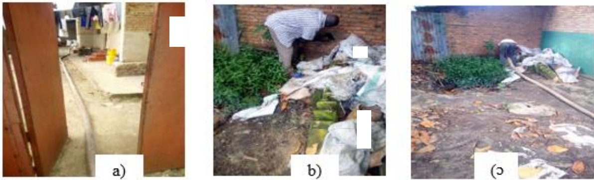
Figure 3.2 : (a) Difficulté de vidange d'une fosse placée derrière la parcelle en zone Cibitoke, (b) et (c) trou fait dans un mur de la clôture pour faciliter l'opération de vidange en Zone Kinama
