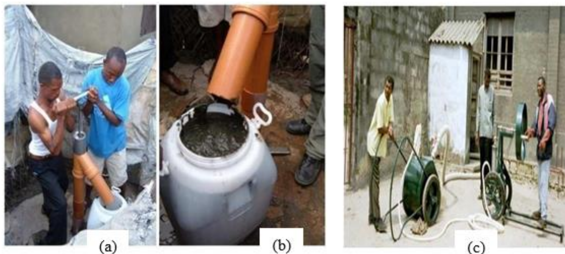
Figure 1.2 : Vidange semi-mécanique : (a) et (b) Sugden, 2005 ; (c) Photo MAPPET klingl et al. , 2002
