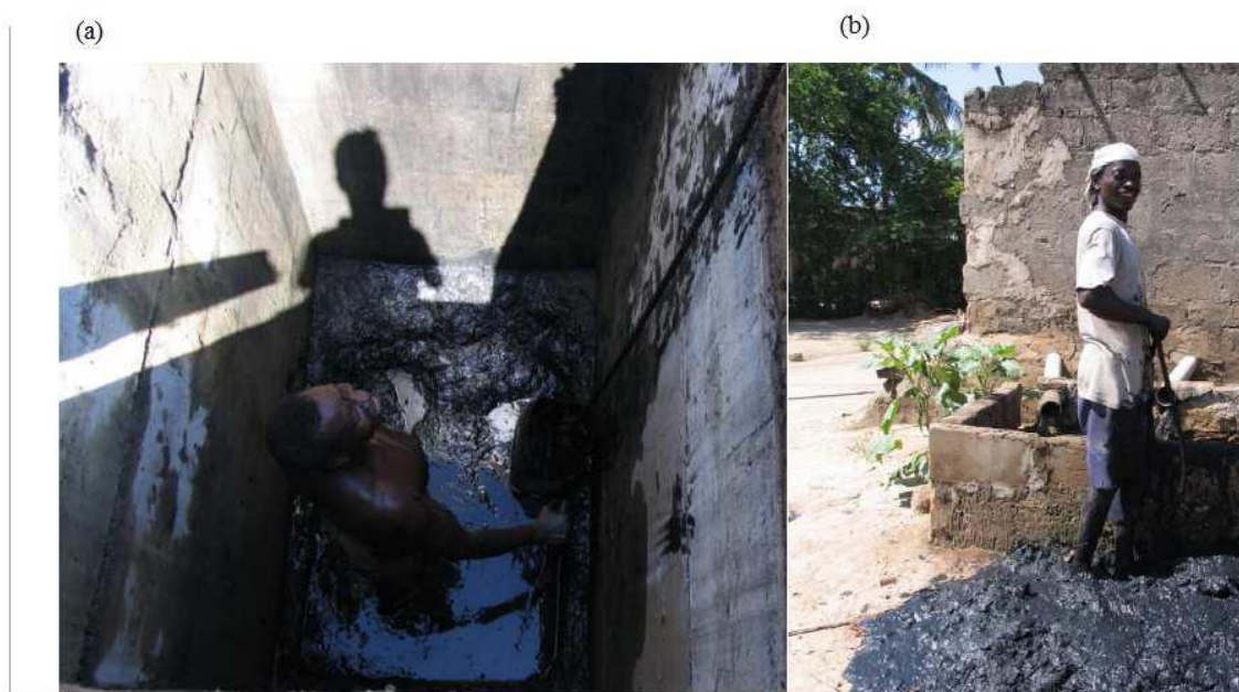
Figure 1.3 : Vidange manuelle d'une fosse à Dar es Salam : (a) homme se trouvant dans la fosse (b) à l'extérieur de la fosse un autre déverse les boues dans la cour de la parcelle (Sölden, 2005)
