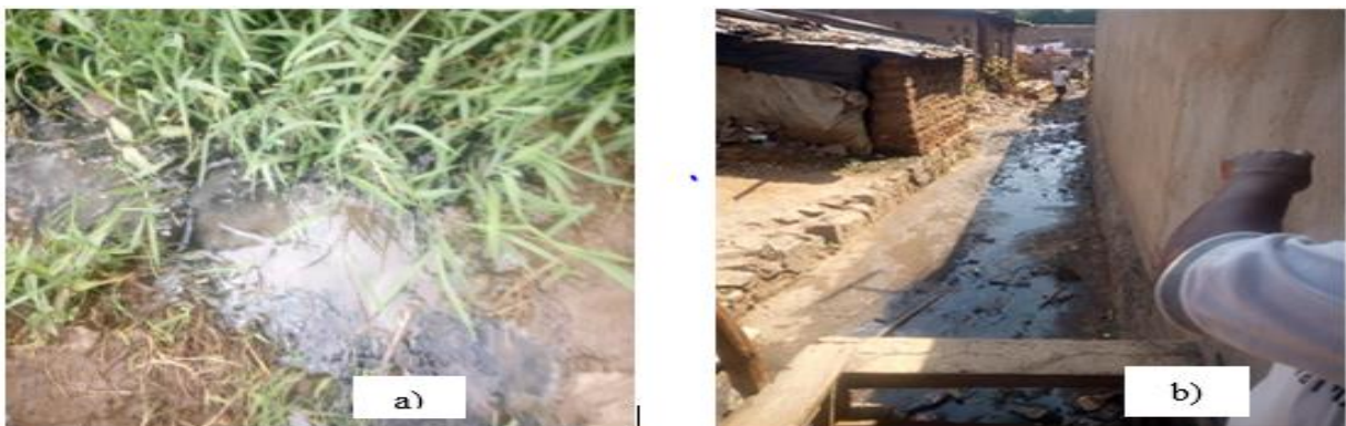
Figure 3.5 : a) Boues déversées dans un canal non entretenu à Carama b) collecteur d'eaux pluviales et des boues de vidange pendant la saison pluviale à Kanyosha.
