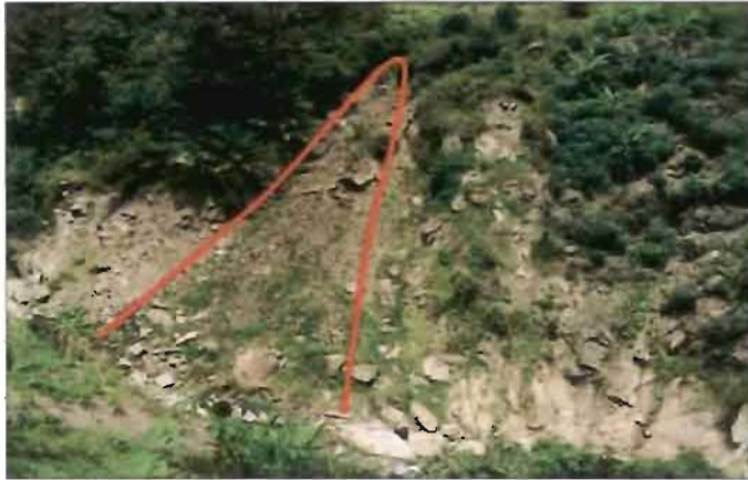
Photo 9 : Glissement au contact de la Gikoma à Buhayira
