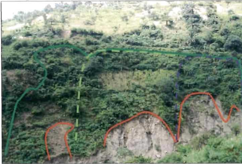
Photo 8 : Glissement de terrain en 4 phases à Mbirira
