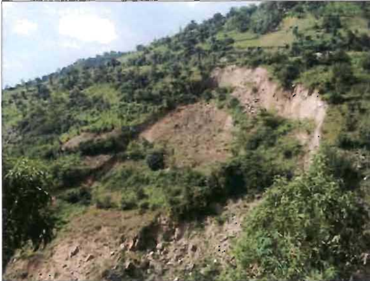
Photo 13 : Glissement complexe à Mbirira
