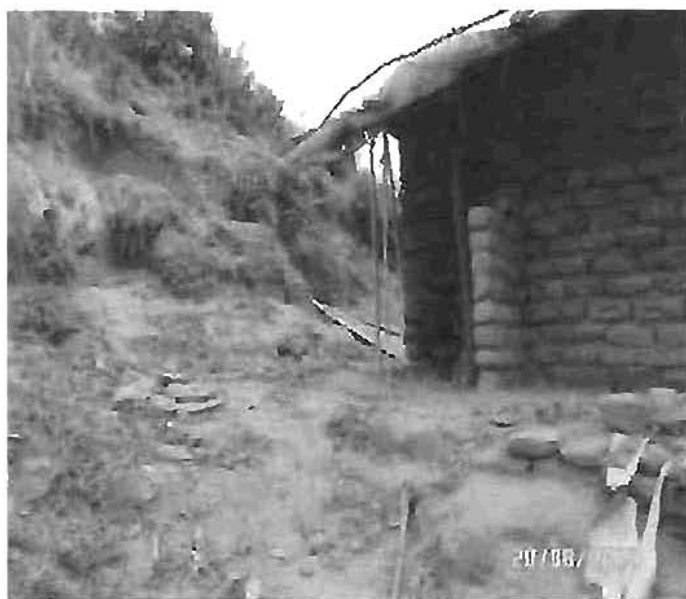
Figure 53: Une maison en briques adobes détruite par un glissement de terrain
