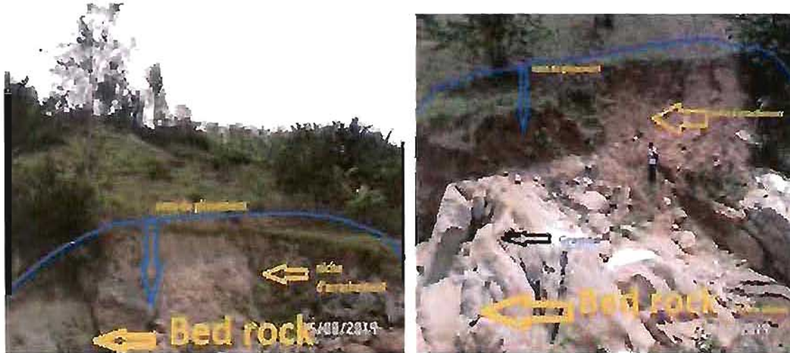
Figure 19: Mouvement de masse de Bona3 et de Bona4 (Sheet érosion)
