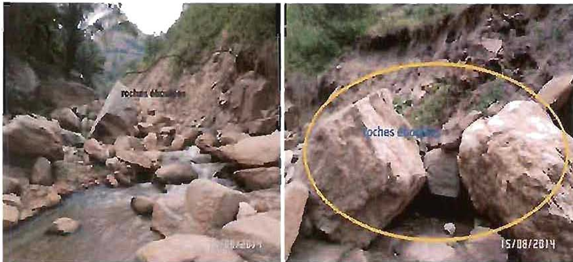
Figure 22: Eboulements de Kwigere et Eboulements de Bona
