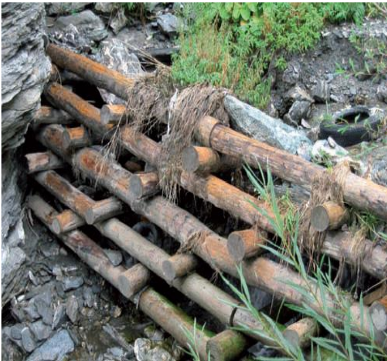
Figure 13 : Illustration du caisson double (Peeters et al. , 2018b)
