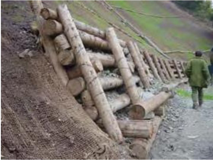
Figure 14 : Illustration du caisson simple (Peeters et al. , 2018b)
