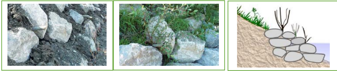
Figure 5: Enrochements avec des piquets vivants enfoncés dans les joints ou les ouvertures entre les rochers.
