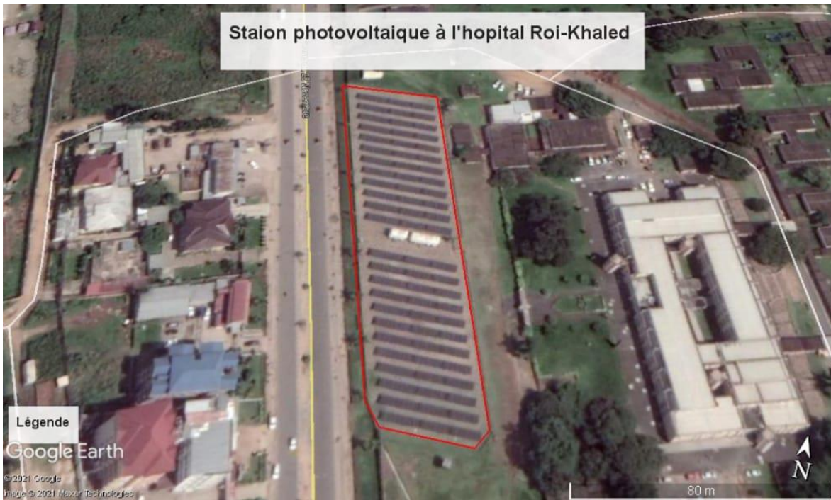
Figure II.2: Centrale photovoltaïque au CHUK à Bujumbura
