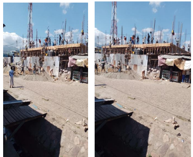
Gâchage et coulage du béton, Rue n o 10 à Bwiza Photo du 10/06/2025
