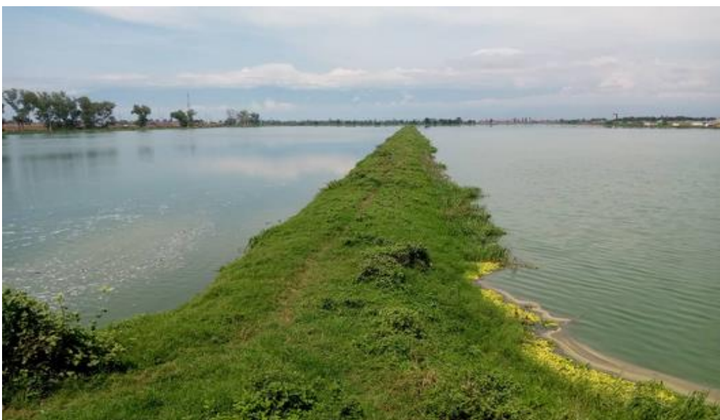
Photo 8 : Bassins de maturation de la STEP BUTERERE
