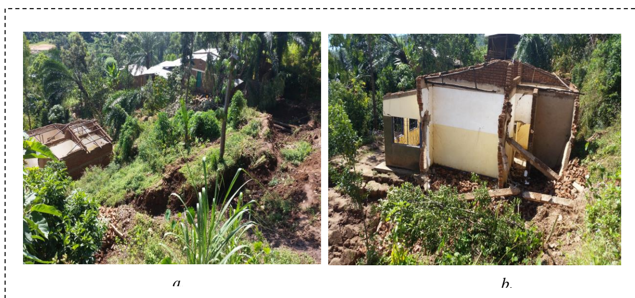
Figure 0-2 : Glissement des terrains & effondrement (a) et destruction des bâtiments (b) au quartier Mutumba
