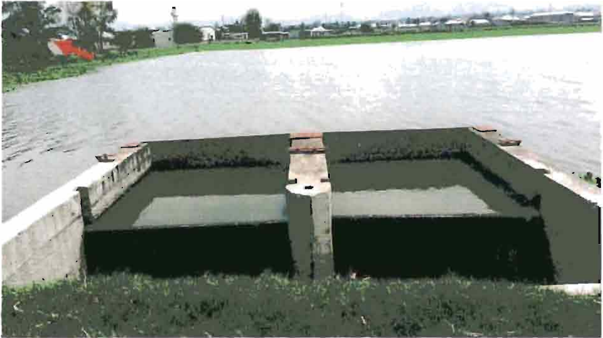
Photo 14 : Une des lagunes de la station d'épuration des eaux de la zone Buterere (source, cliché auteur le 25/8/2016)
