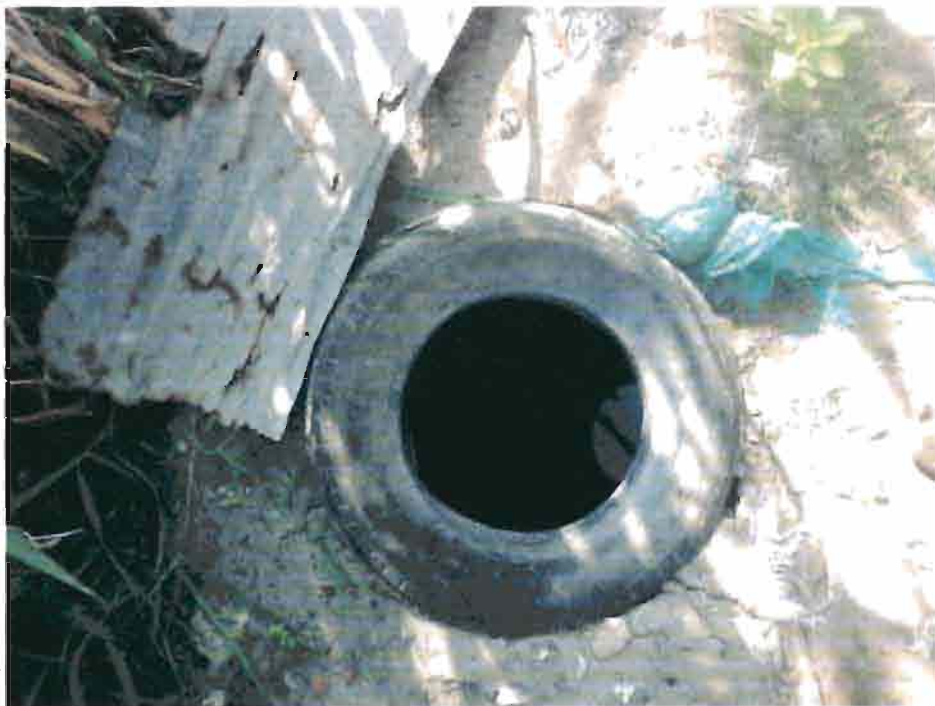
Photo 16 : Puits où on puise de l'eau de cuisine pendant la saison des pluies (source, cliché auteur le 25/08/2016)
