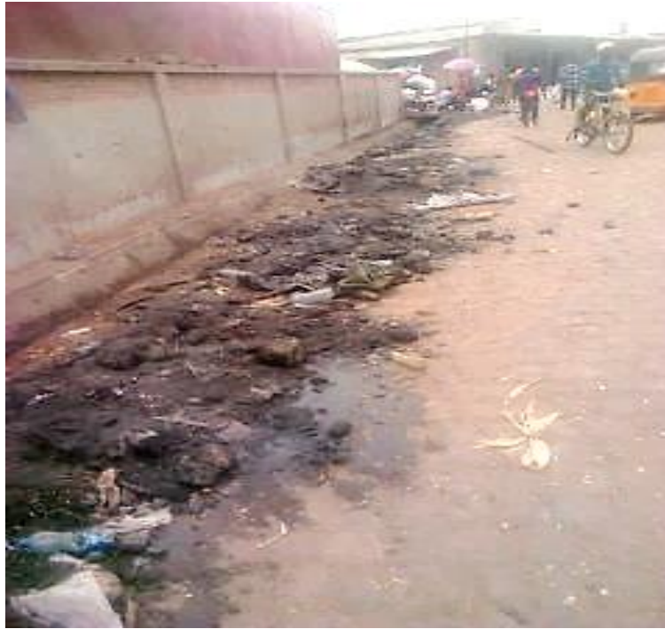
Photo 8 : Caniveaux curé, déchets déversés dans la rue sur le 23 ème Avenue, quartier Ruyigi à Kinama
