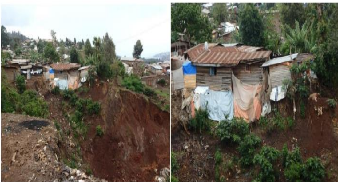
Figure 18. Maisons construites sur les sites à haut risque.
