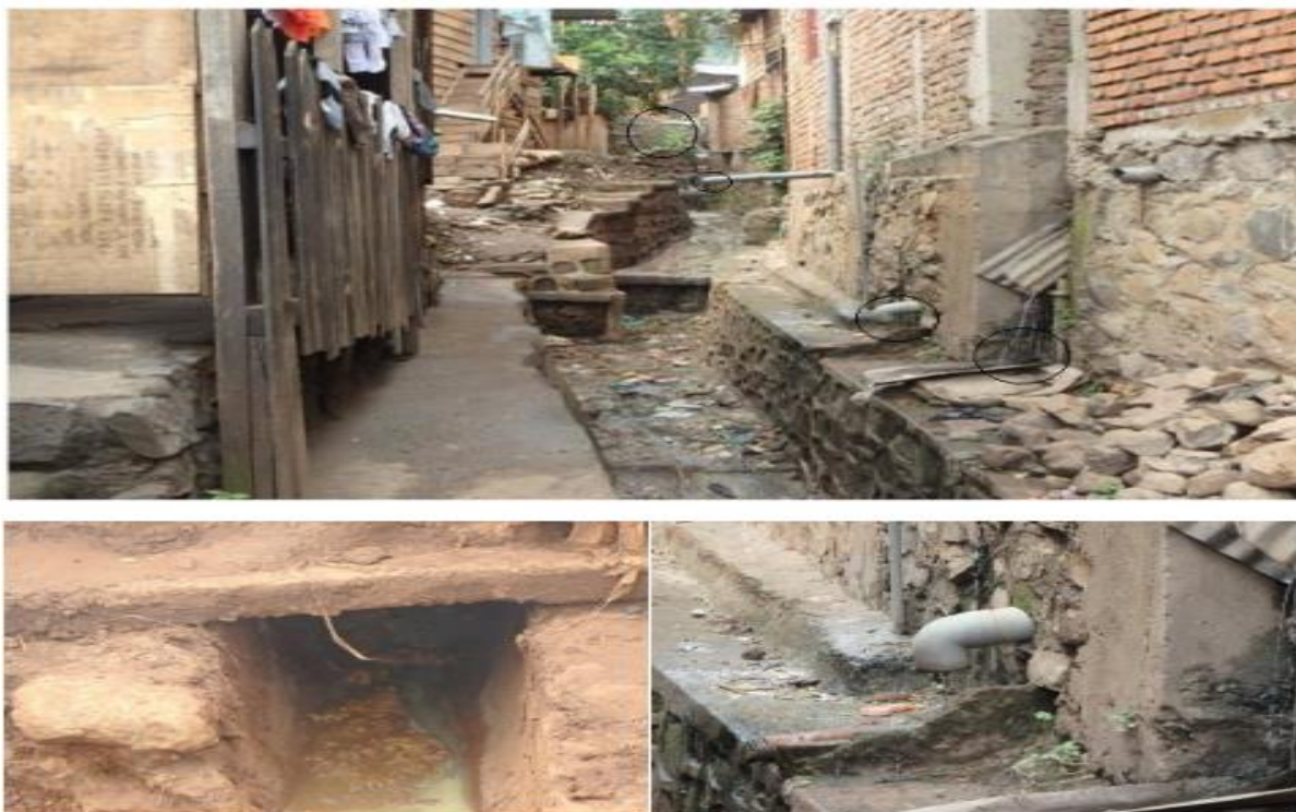
Figure 21. Vues de pratiques de rejet des eaux grises et noires dans les rigoles de la ville (Alex Lina 2016)
