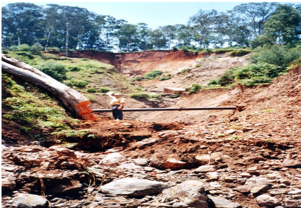
Figure 22. Glissement de terrain et coulée de pierres du Lycée Wima.
