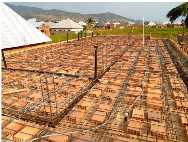
Figure 6: Photo illustrative des éléments constituant des planchers en hourdis prise sur chantier se trouvant à Ruziba à Bujumbura Mairie par Edmond NIZIGIYIMANA
