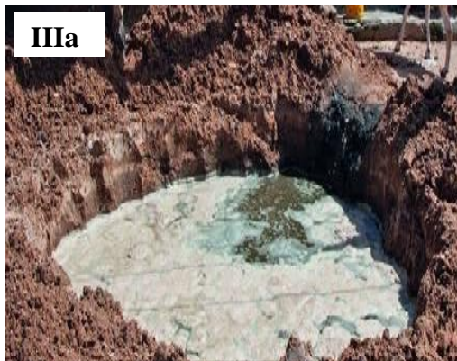
Enterrement des boues vidangées
